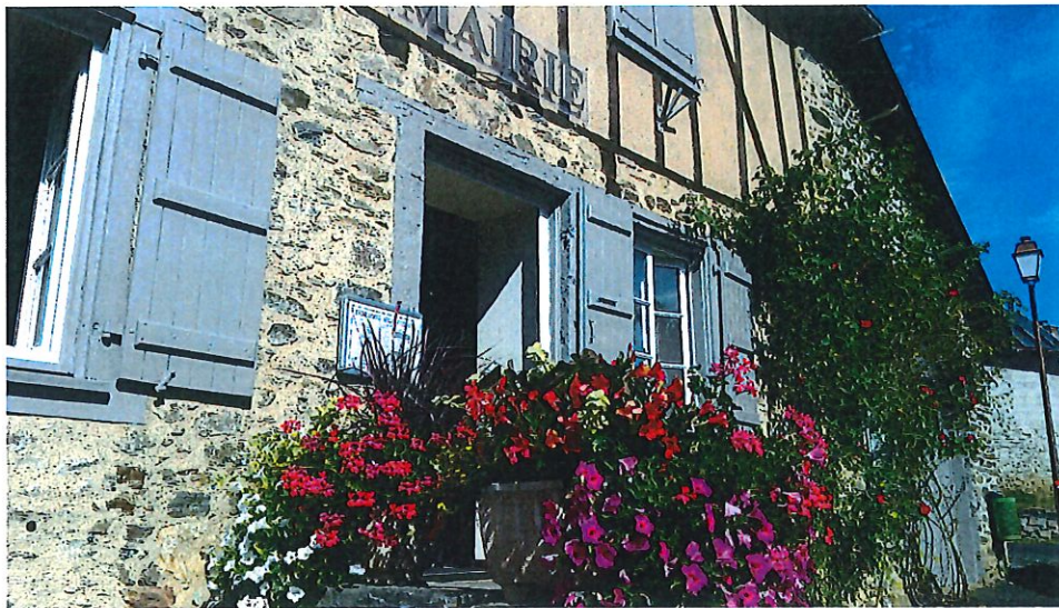
Fleurissement, façade de la Mairie
